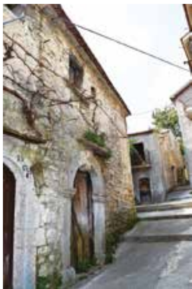
Edificio storico in muratura a Longano (Is)
